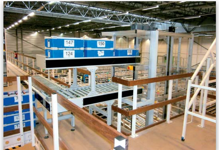
Alimentation sur mezzanine
