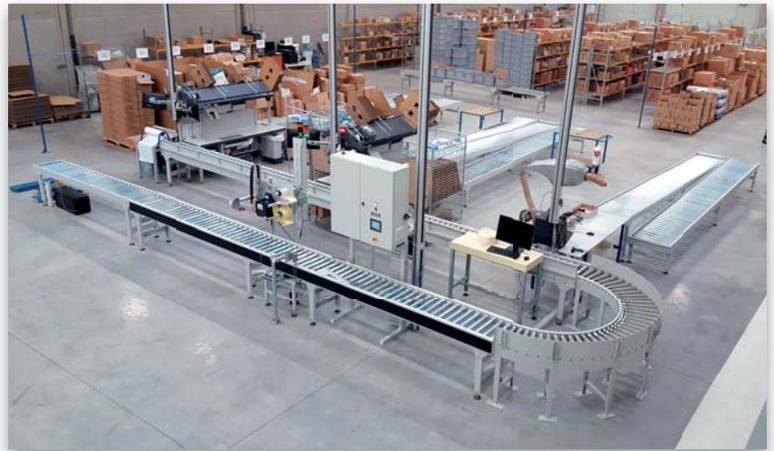
Ligne complète de préparation de commandes
